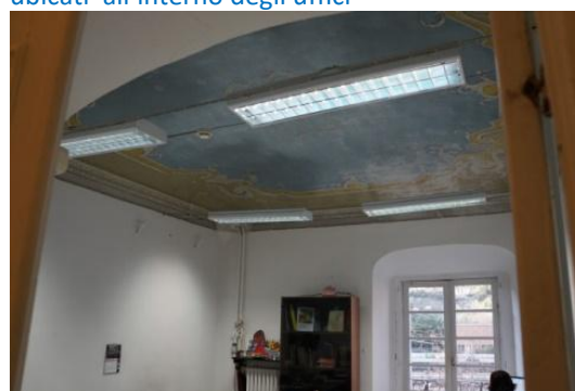
Figura 4.15 - Particolare dei corpi illuminanti ubicati all’interno degli uffici
