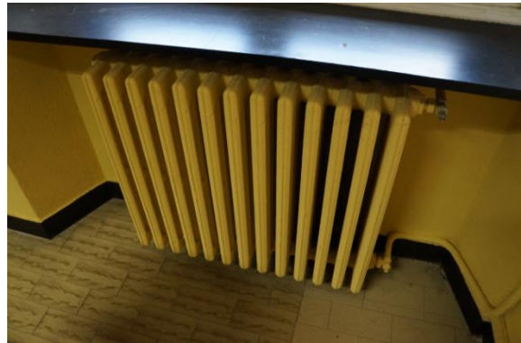
Figura 8.5 – Particolare terminali di emissione
