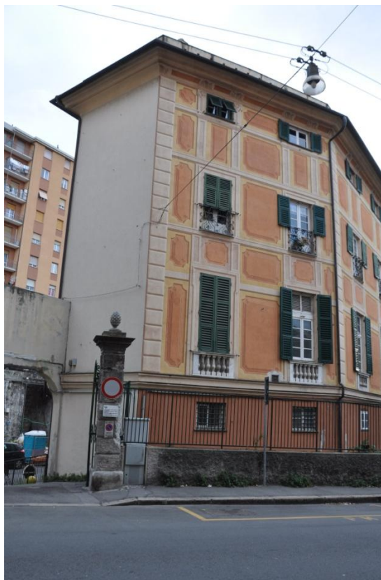
Figura 1.1 - Vista dell'ingresso a sud-ovest
