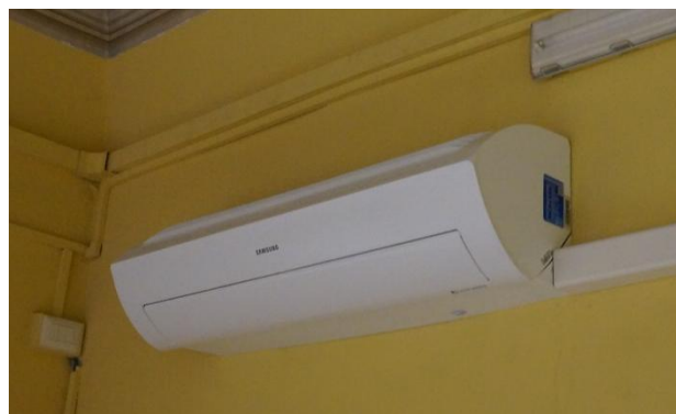
Figura 4.14 - Particolare di unità interna del sistema di climatizzazione estiva
