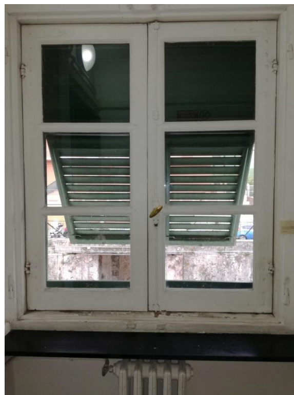
Figura 4.4 - Particolare dei serramenti
