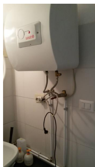
Figura 4.11 - Particolare di un boiler elettrico per la produzione di acqua calda sanitaria
