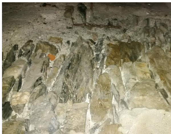
Figura 4.2 - Particolare della muratura esterna nella zona basamentale
